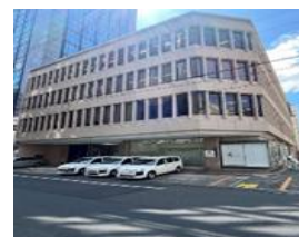
大阪事務所社屋(耐震工事リニューアル実施)
