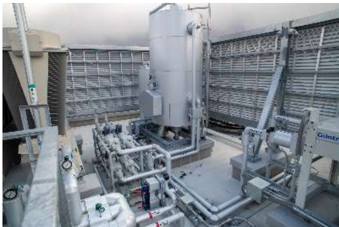
地中熱、太陽熱を給湯や空調に利用する装置
