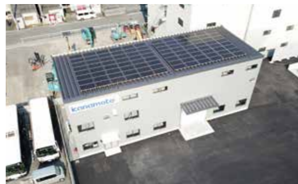
屋上に太陽光発電設備を設置した京都営業所
