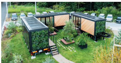
オフグリッドトレーラー棟
