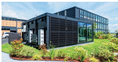
オフグリッドユニット棟
