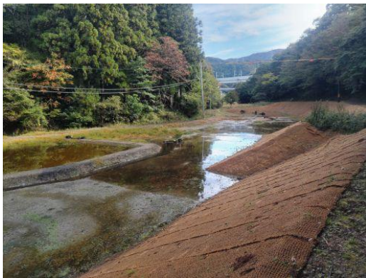
自然復元工事によって創出した湿地
