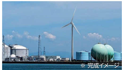
北ガス石狩風力発電所（建設中）
