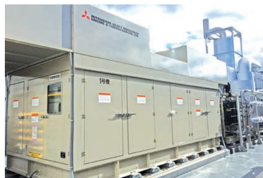
BOS*機能付のガスコージェネレーション ※ブラックアウトスタート:停電時に外部電源なしでエンジンを起動・給電する機能
