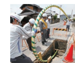
ポリエチレン管の敷設
