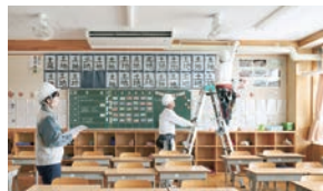
小学校のガス空調設置工事
