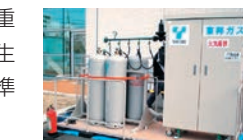
移動式ガス発生設備
