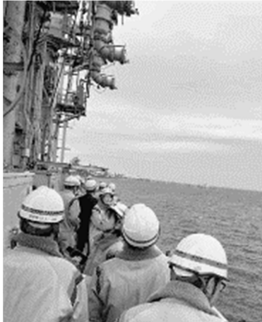
Site visit to the landing pier for LNG carriers (Ohgishima LNG Terminal)
