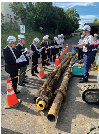
ねずみ鋳鉄管の取替工事 (東京ガスネットワーク) 視察時の様子
