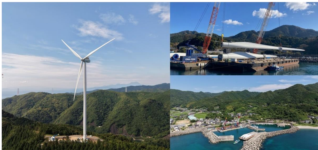
（苓北・天草風力発電所 建設地及び建設風景）
