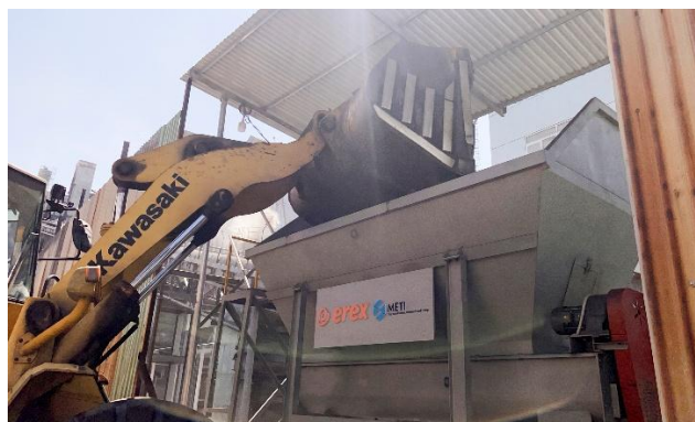
木質チップの投入状況
