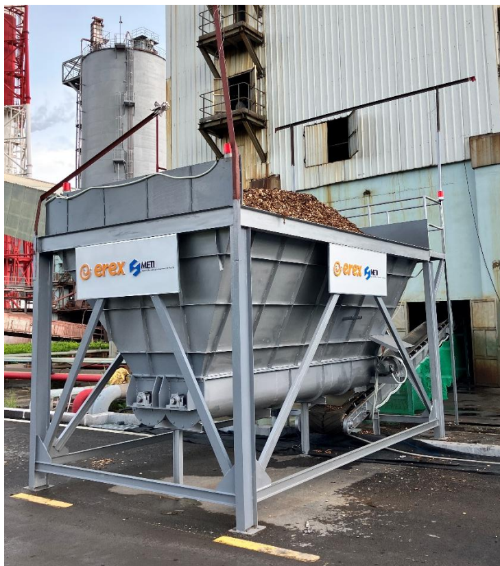
【写真】バイオマス燃料投入状況
