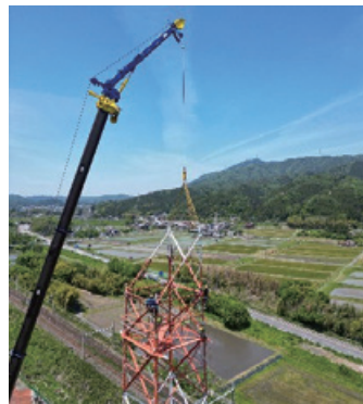
鉄塔の建替工事の様子
