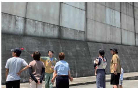
発電所見学会 (防波壁を説明している様子)
