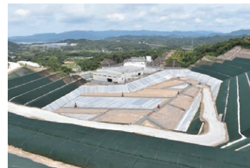
御坊リサイクルセンター 第2期管理型最終処分場
