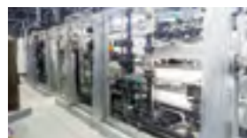
水資源を循環利用する 三重リサイクルセンター 水処理施設 RO 膜処理装置
