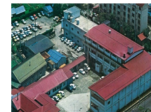
KOA ISEI HQ Factory
