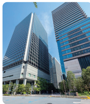
飯野ビルディング(2011年竣工/写真左) 日比谷フォートタワー(2021年竣工/写真右)
