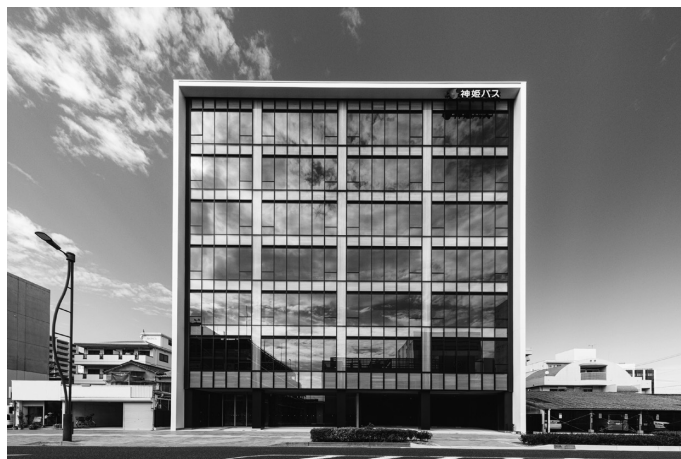
2025年9月竣工の神姫バス姫路本社ビル
