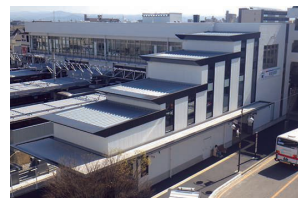
新安城駅改良（橋上駅化）
