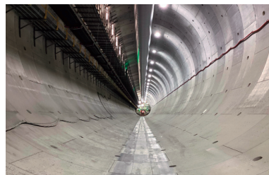
第一首都圏トンネル（梶ヶ谷工区）
