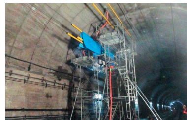
大規模改修工事
