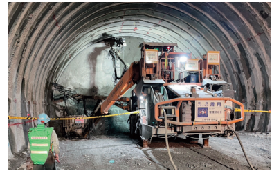
南アルプストンネル（山梨工区） 本線トンネルの掘削
