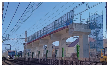
構築した高架橋
