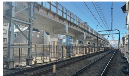
京王線連続立体交差事業
