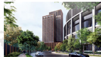
サービス アパートメント 外観イメージ
