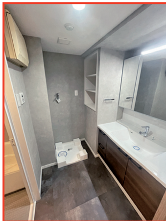
節水型洗面器具への更新 (プロスペクト清澄庭園)
