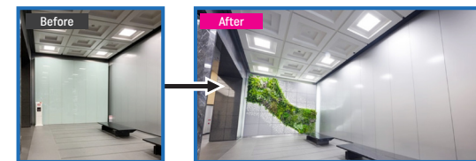
共用部改修（Daiwa北浜ビル）
