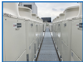
空調設備の更新 (Daiwa銀座ビル)
