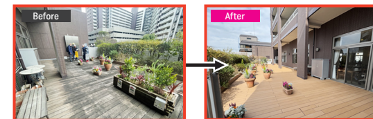
共用部改修（グッドタイムリビング亀戸）
