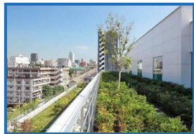
屋上庭園の設置 (Daiwa麻布テラス)
