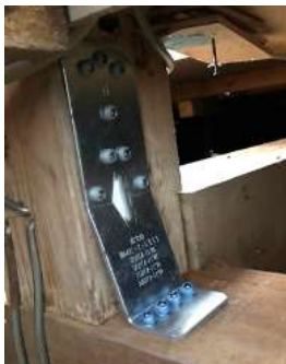
耐震補強金物を設置
