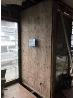
耐震壁の新設
