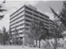
瓦町ビル 1962年竣工
