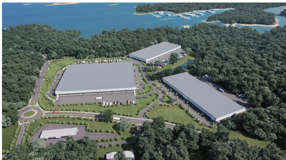
アトランタ物流倉庫開発 (米国ジョージア州)
