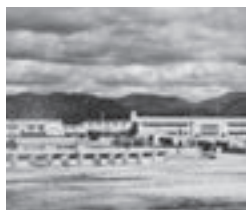
阪神競馬場 1949年竣工
