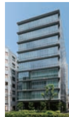
御成門ビル 2009年竣工
