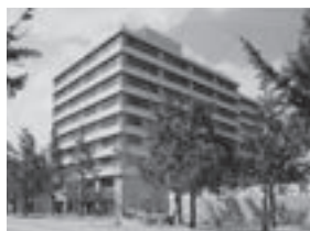
瓦町ビル 1962年竣工
