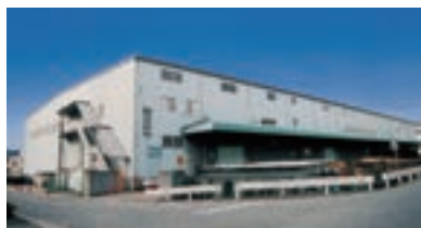
枚方倉庫 1983年竣工
