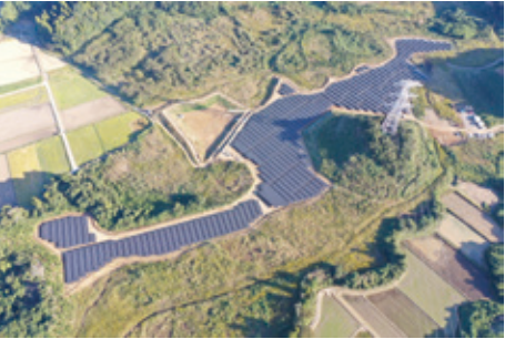
千葉県太陽光発電所
