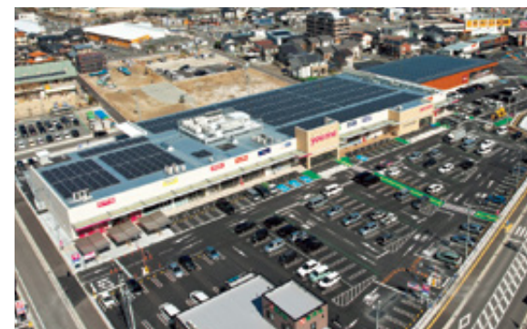
太陽光発電による再生可能エネルギーを使用
