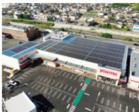
「ゆめマート山陽」の太陽光発電パネル
