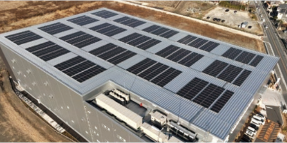
アイネット第1データセンターへ電力を供給する太陽光発電所
