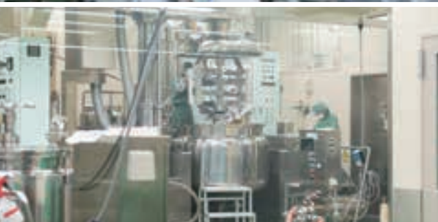
開発段階から商用生産への円滑な移行を支える製造設備
