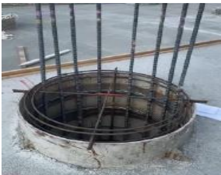
TPボトムパイルバスケット工法の例
