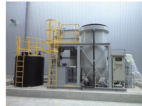
工業用水処理設備の例 (凝集沈殿ユニット)
