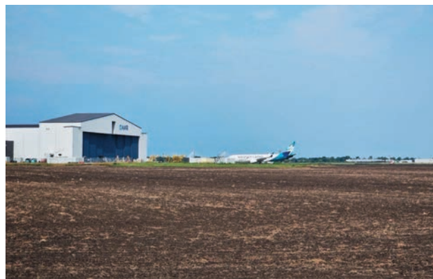
ATM社の工場建設予定地
