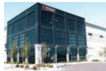
米国ユタ州の工場
