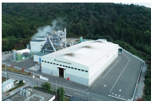
木質バイオマス発電（島根県松江市）
