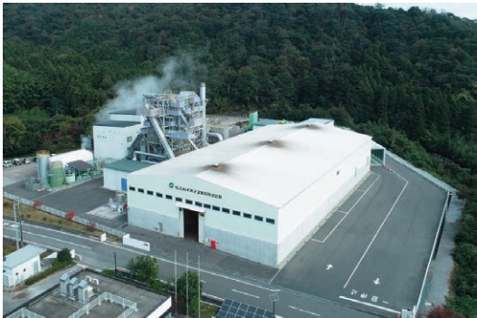
木質バイオマス発電（島根県松江市）
