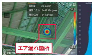
高所のエア漏れも検知して可視化
