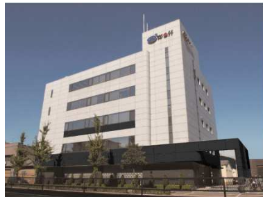
本社(大阪市西淀川区)
