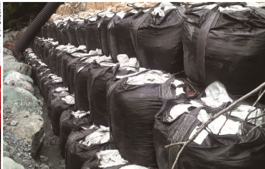
耐候性大型土のう
