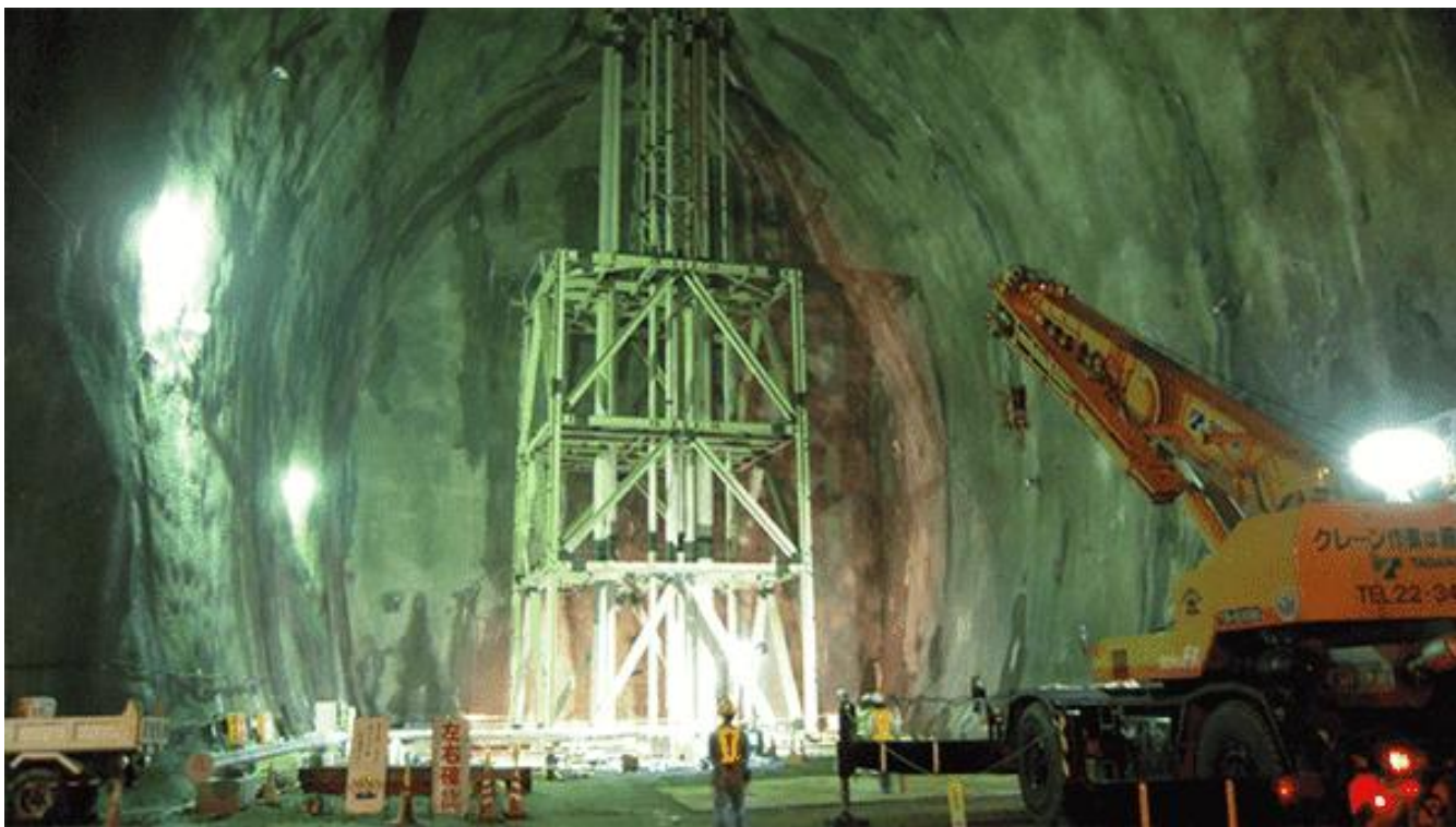
波方国家石油ガス備蓄基地 建設当時の地下岩盤貯槽 (写真提供：独立行政法人エネルギー・金属鉱物資源機構)
