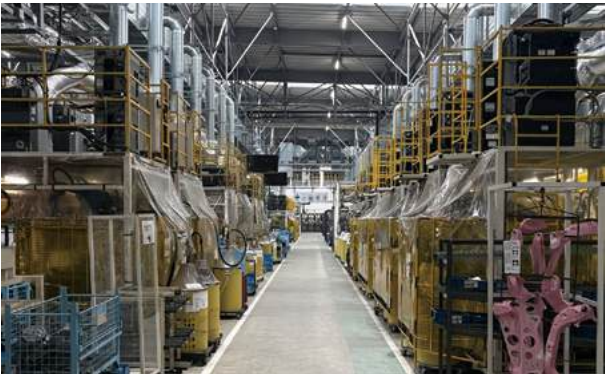
設置中の組立設備 愛知工場から25年10月までに移管を完了
