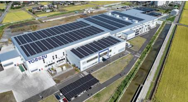
太陽光パネル
