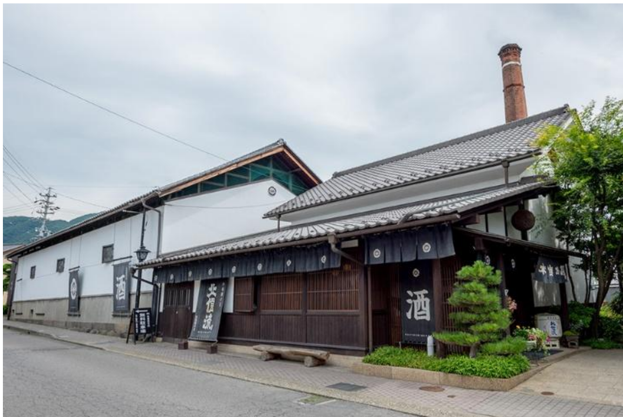
松葉谷本店 建物外観
