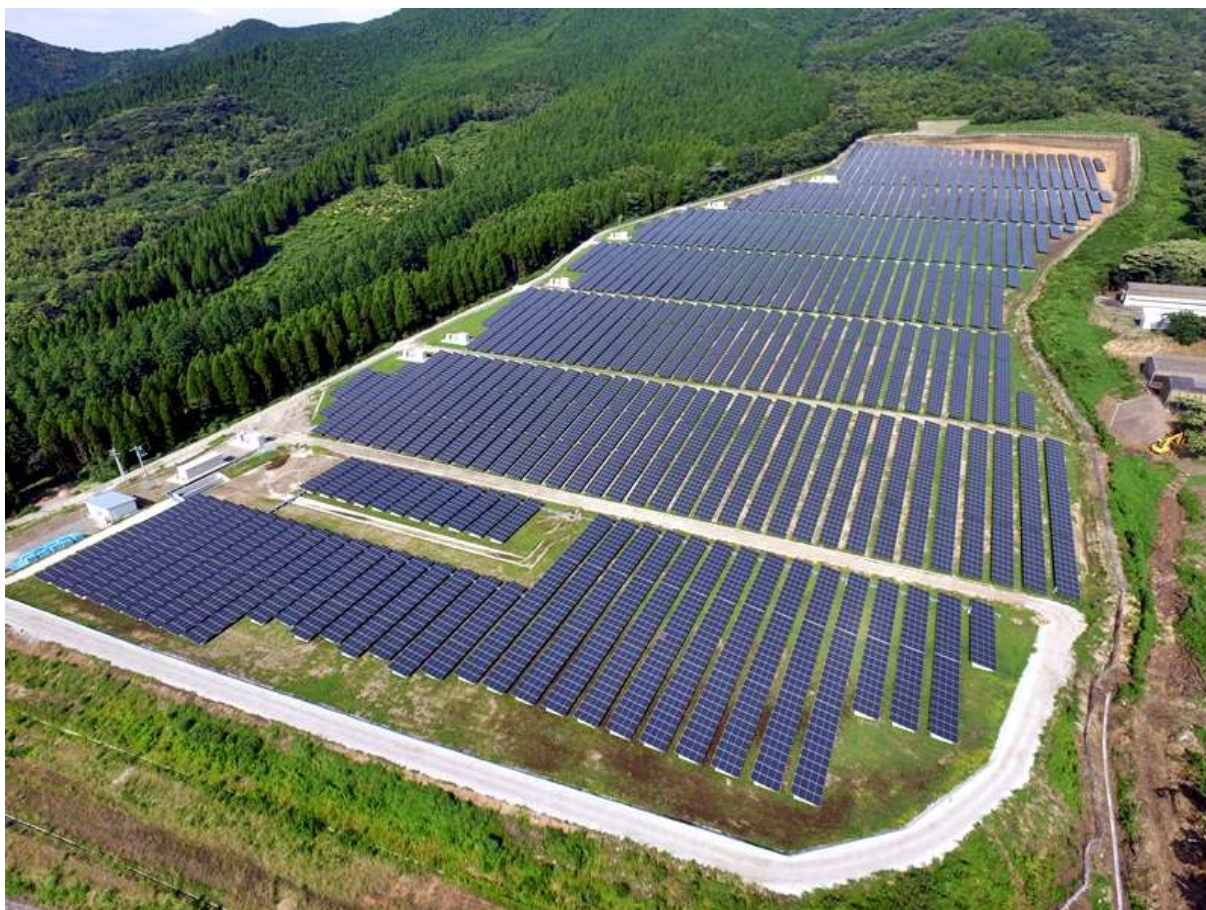
くまもとんソーラー発電所(所在地:熊本県菊池市)
