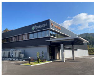
須賀川新工場
