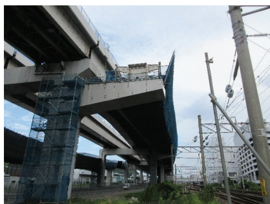
【九州地方整備局向け黒崎西バイパス出口部分高架橋】
