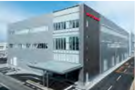
玉村工場5号棟(群馬県佐波郡玉村町)
