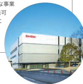
滋賀工場新棟竣工 (2014年)
