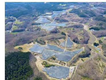
鮫川青生野太陽光発電所
