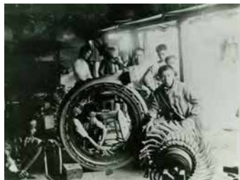
電気機械類の修理の様子
